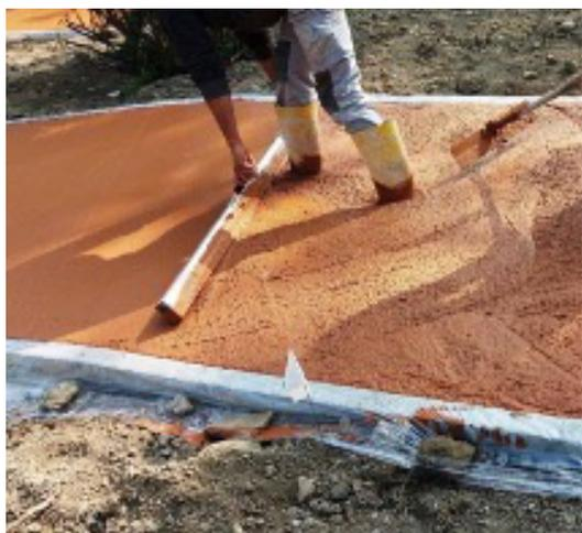
La componente luminescente può essere realizzata in diverse colorazioni (giallo, blu, rosso, etc.) offrendo una vasta possibilità di combinazioni sia cromatiche che di tessitura superficiale, grazie alla combinazione di aggregati, di cementi colorati e anche mediante l'utilizzo di speciali ossidi colorati.
