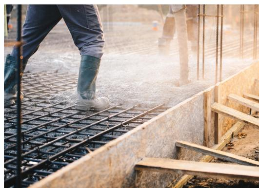
Pertanto, basare la scelta, ma soprattutto la prescrizione di capitolato del calcestruzzo autocompattante, solo sull'indicazione di una classe di fluidità (trascurando, quindi, viscosità, resistenza alla segregazione e passing ability) può
