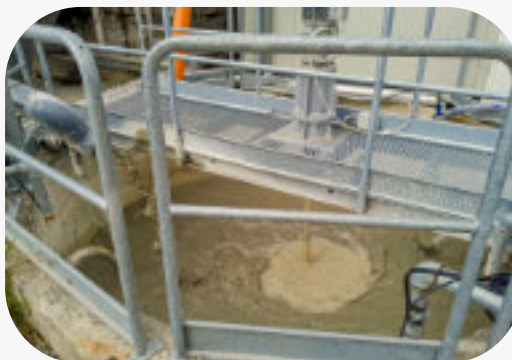
Vasca acqua di processo con agitatore
