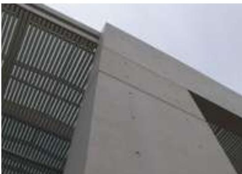
le strutture facciavista utilizzare uno slump di riferimento di  $18 \pm 2$  cm (classe di consistenza S4). Per il calcestruzzo da mettere in opera mediante pompa si possono utilizzare anche conglomerati con classe di consistenza S5 purché a livello compositivo si adottino i necessari provvedimenti per ottenere impasti coesivi e resistenti alla segregazione.
