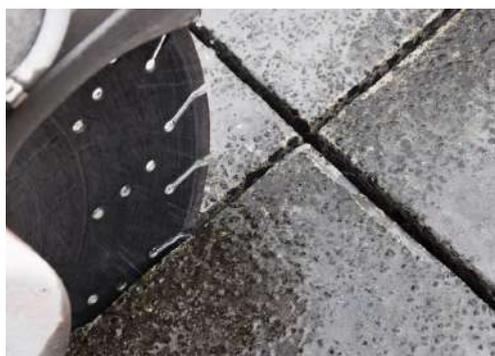
Esistono diverse modalità realizzative: utilizzo di barrotti in acciaio liscio disposti perpendicolarmente alla interruzione del getto nella mezzera della piastra di diametro variabile tra 14 e 20 mm, lunghi almeno 45 cm e disposti ad interasse di circa 30 cm (3 ogni metro lineare) oppure (e questa ormai è la situazione più ricorrente) si possono impiegare giunti preformati da scegliere in funzione dello spessore della piastra e dei carichi da trasferire.
