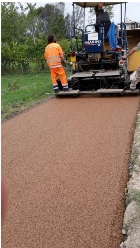
permeabilità (tipicamente sabbiosi) con velocità di infiltrazione non inferiore a 12.5 mm/ora. Tuttavia, anche se la permeabilità dovesse essere inferiore (2.5 o 0.5 mm/ora tipici di terreni argillosi), il volume di acqua di ruscellamento superficiale risulta comunque inferiore – costruendo una pavimentazione drenante – rispetto a quello del solo terreno naturale. In ogni caso è buona norma non realizzare pavimentazioni su terreni naturali con un “infiltration rate” inferiore a 2.5 mm/ora.
