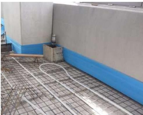
Nelle pavimentazioni di grande estensione superficiale, allorquando non è possibile completare la realizzazione dell'opera nell'arco di una sola giornata lavorativa, l'esecuzione della pavimentazione avverrà segmentando il pavimento in diversi settori. Le porzioni di pavimento già gettate e quelle limitrofe che debbono ancora essere realizzate identificano un giunto di costruzione, la cui realizzazione necessita dell'adozione di alcuni accorgimenti progettuali e costruttivi.
