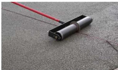
nel calcestruzzo venga prevista la presenza di un additivo con caratteristiche collaterali ritardante. In termini di slump, il calcestruzzo drenante possiede valori nell'intervallo 20-40 mm.
