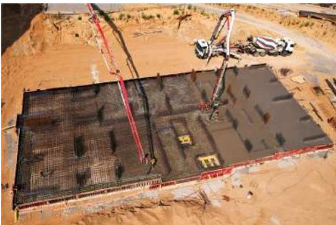
Noto il calore di idratazione unitario del cemento ( $q_3$  oppure  $q_7$ ) prescelto e stabilito il dosaggio di cemento ( $c$ ), il calcolo del massimo riscaldamento in condizioni adiabatiche ( $\Delta T$ ) potrà così essere effettuato:
