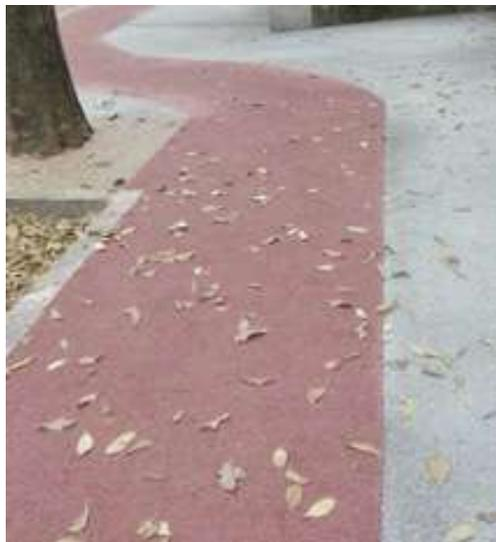
Infine, si segnala come l'efficienza della pavimentazione in termini di permeabilità può essere compromessa dall'accumulo di sporco, di materiale fine e di fogliame sulla
