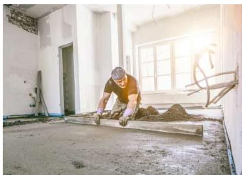
Le proprietà delle malte/betoncini per massetto vengono stabilite dalla **norma europea EN 13813**, in accordo alla quale il conglomerato viene identificato in base alla **natura del legante** utilizzato per il suo confezionamento (ad esempio, **CT cementizio oppure CA a base anidrite, etc.**), **alla resistenza a compressione (C) e flessione (F) a 28 giorni** (CT C30/F6 è un massetto a base cementizia avente resistenza a compressione e flessione a 28 giorni rispettivamente di 30 e 6 MPa).
